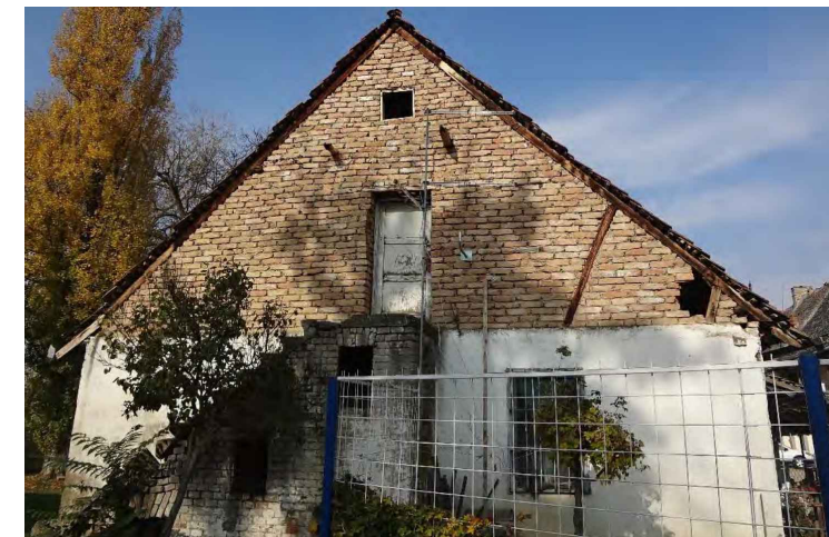
5.2._3. Gospodarska zgrada „A“ - južno pročelje, fotografija: Hrvoje Magdić, 2018.
