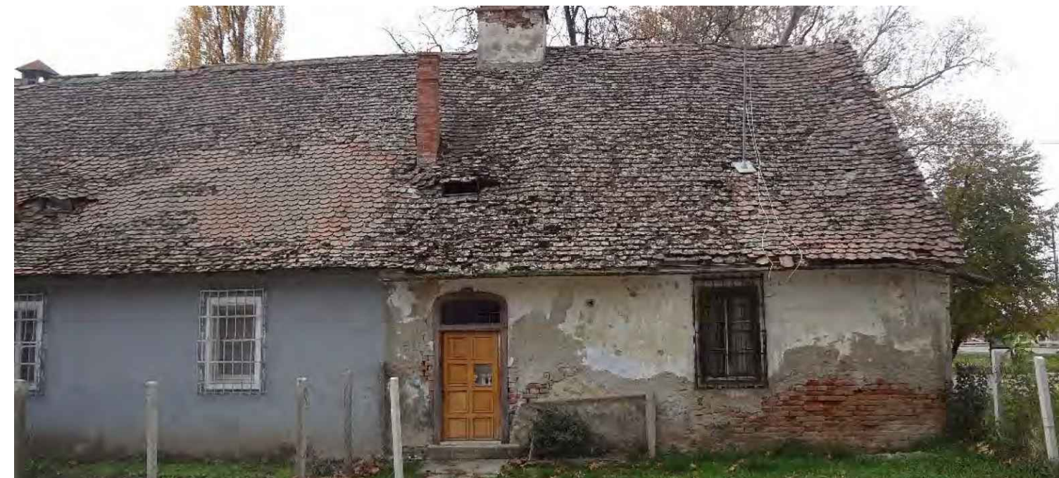
5.2._4. Gospodarska zgrada uz južno krilo Velikoga dvorca, dio zapadnoga pročelja, izvor: Snimka zatečenog stanja pomoćnih građevina dvorskoga sklopa Khuen Belassy, Tablinum d.o.o., 2017.
