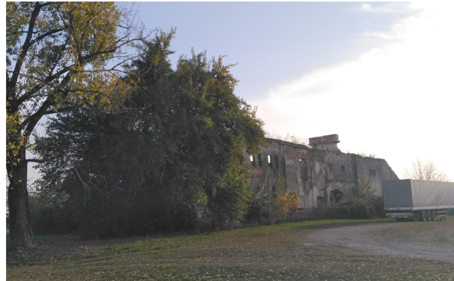
3.2._2. Sjeverozapadno pročelje ruševnog paromlina iz Ulice Križnog puta, fotografija: Hrvoje Magdić, 2018.
