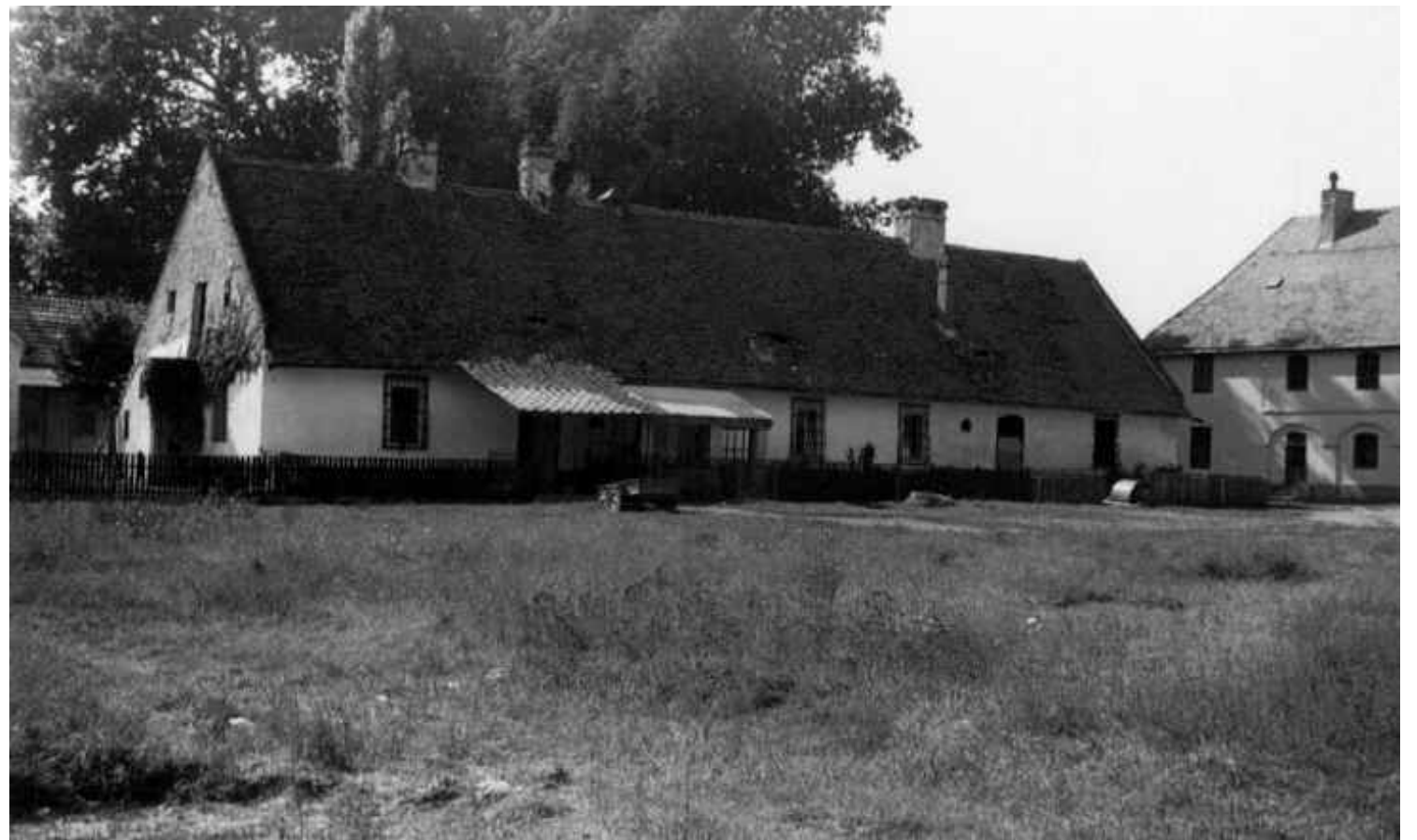
5.1._2. Gospodarska zgrada „A“ 1970.-ih godina, južnoistočno pročelje, izvor: Fototeka Ministarstva kulture RH
