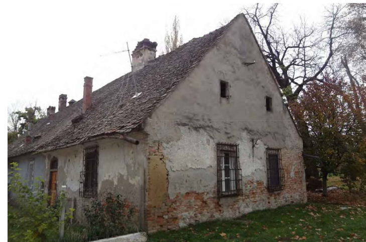
5.2._2. Gospodarska zgrada „A“ - sjeverno pročelje, fotografija: Hrvoje Magdić, 2018.
