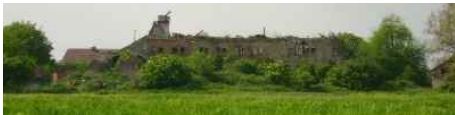
3.2._4. Jugoistočno pročelje ruševnog Paromlina - pogled iz perivoja, fotografija: Hrvoje Magdić, 2018.
