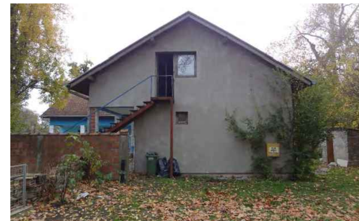
5.2._5. Zgrada nogometnoga kluba izgrađena na mjestu povijesne gospodarske zgrade „B“, fotografija: Hrvoje Magdić, 2018.
