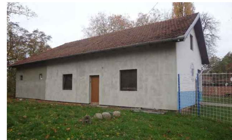
5.2._6. Južno pročelje Zgrade nogometnoga kluba, fotografija: Hrvoje Magdić, 2018.
