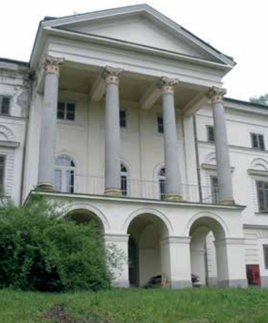
Altana, južno pročelje, foto: M. O. Ščitaroci, 2010.
