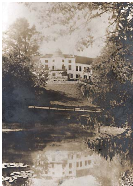
Pogled na dvorac s jezera, 1940.
