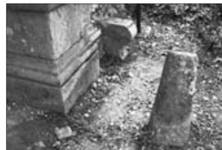
STANCIJA FRANKOVIĆ-VLAČIĆ, GLAVNI PORTAL, ZAPADNO PROČELJE, 2004.
