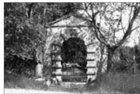
STANCIJA FRANKOVIĆ-VLAČIĆ, GLAVNI PORTAL, ZAPADNO PROČELJE, 2004.
