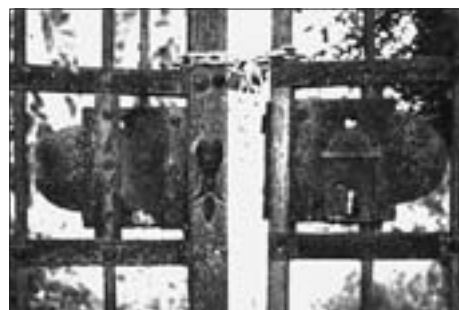
STANCIJA FRANKOVIĆ-VLAČIĆ, GLAVNI PORTAL, ZAPADNO PROČELJE, 2005.
