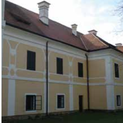
Obnovljeni dio zapadnog pročelja, foto: Z. Laljek
